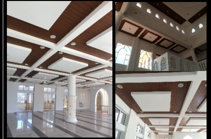
Masjid Seremban Jaya @ Seremban.
